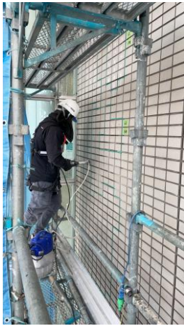
現場作業風景
